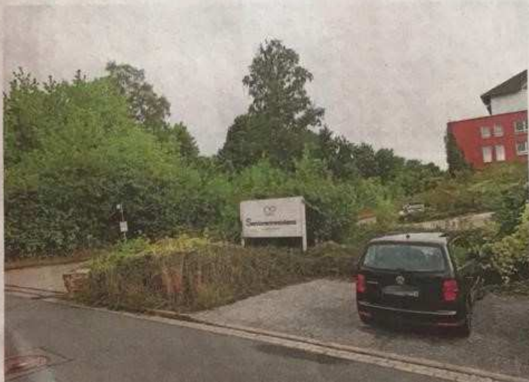
Direkt neben der Seniorenresidenz im Greifpark soll (links) ein Komplex mit 85 Wohnungen, einer Tagespflege und einem Stützpunkt für einen ambulanten Pflegedienst entstehen.
